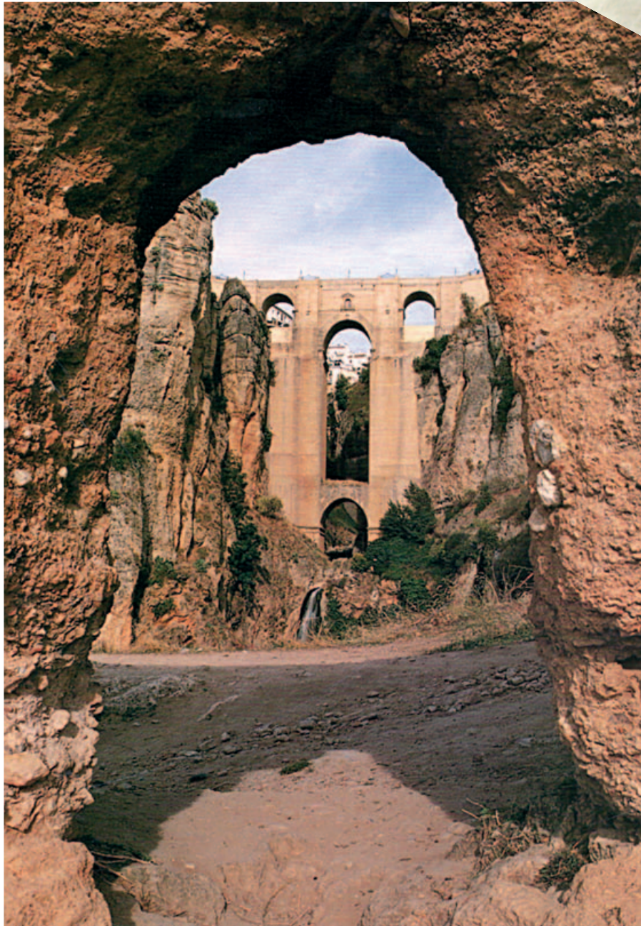
Puente Nuevo de Ronda; fotografía de Carlos Serrano
