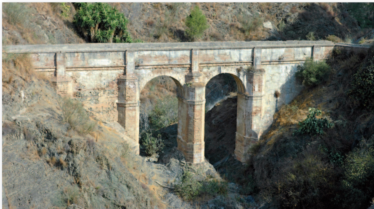
Obra de fábrica sobre el arroyo Hondo. Acueducto de San Telmo. Málaga
