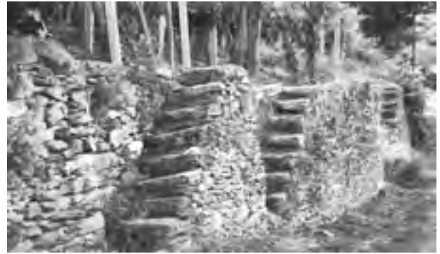
Escaleiras nos muros dos socalcos en Paradelas (Castro Caldelas)
