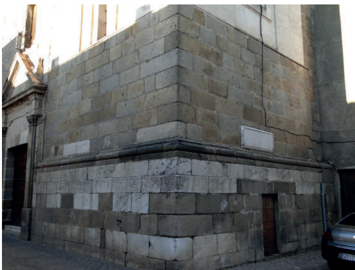
Fig. 5: Sillares del zócalo y primer cuerpo de la torre nueva
