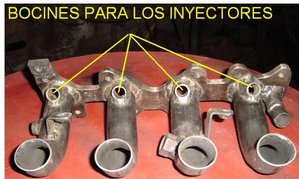
Figura 12.1. Cordón de soldadura en los bocines
