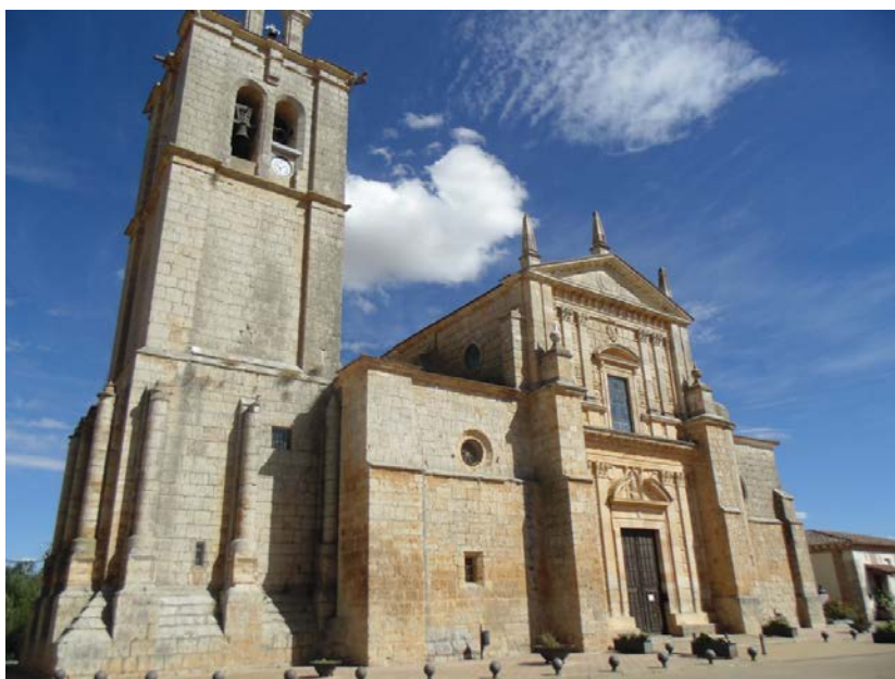
Fig. 3. Iglesia de la Asunción. Fachada principal y torre. Lantadilla (Palencia).
