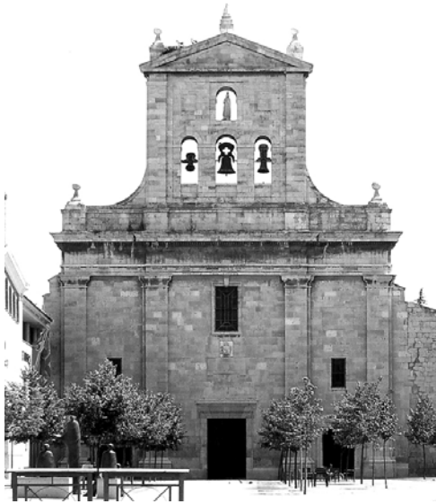
Fig. 5. Iglesia del convento de San Pablo. Fachada. Manuel Turrillo. Palencia.
