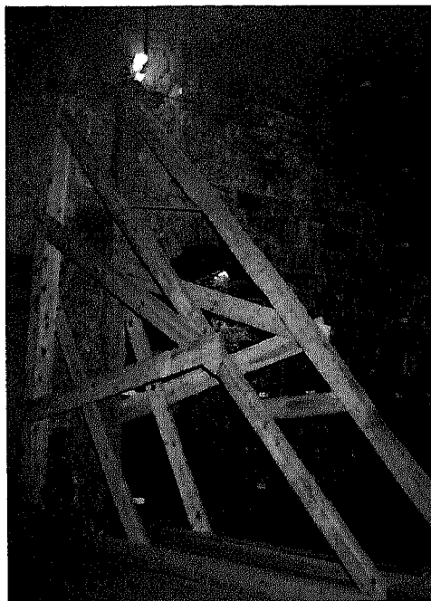
FOTO 3: Apuntalamiento provisional instalado durante las obras de restauración de las cubiertas en 1991.
