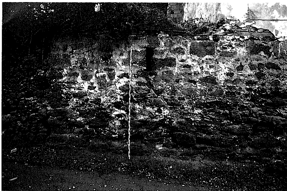
FOTO 12: En 1935 se derribaron las antiguas dependencias unidas a la iglesia pero el escombros se acumuló delante de la fachada. El agua de lluvia empapa ese escombros y la humedad se va transmitiendo a los cimientos con disgregación de los morteros de unión entre las piedras.
