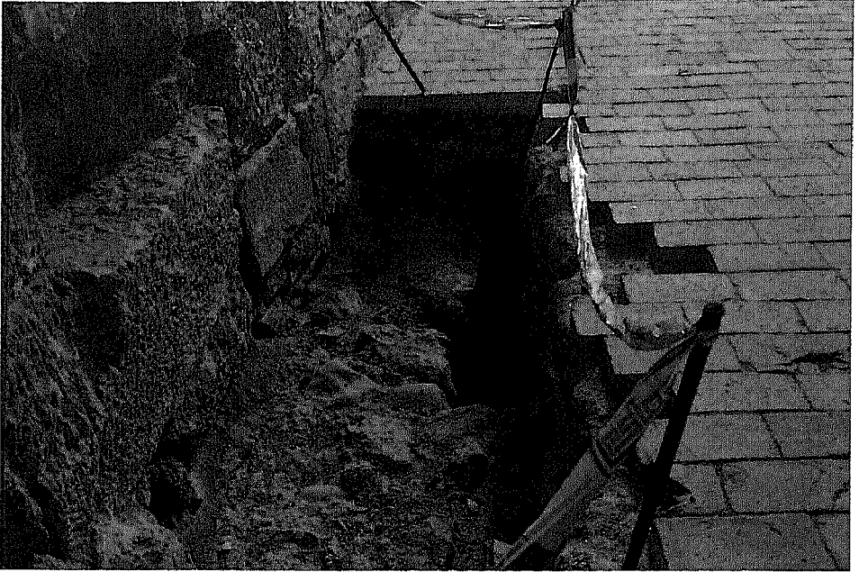
FOTO 18: Aspecto de la cata que se realizó en el interior del templo.
