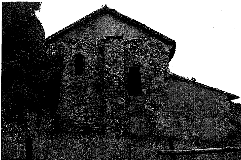
FOTO 7: Estado actual de la fachada Sur.
