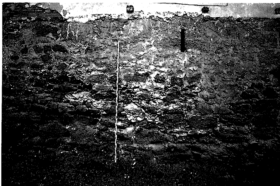
FOTO 13: Efectos de la humedad sobre los morteros de unión entre las piedras.
