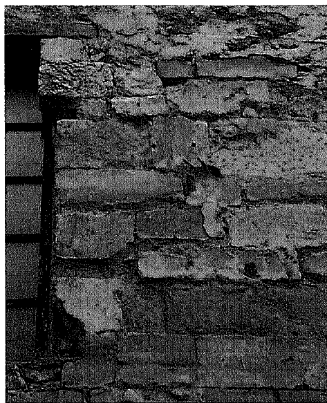
FOTO 27: En esta imagen se puede ver el extensómetro situado sobre una fisura en un sillar —a la derecha de la ventana—. Este sistema permite medir las variaciones estacionales y precisa, por tanto, del plazo de un año para dar valores significativos.
