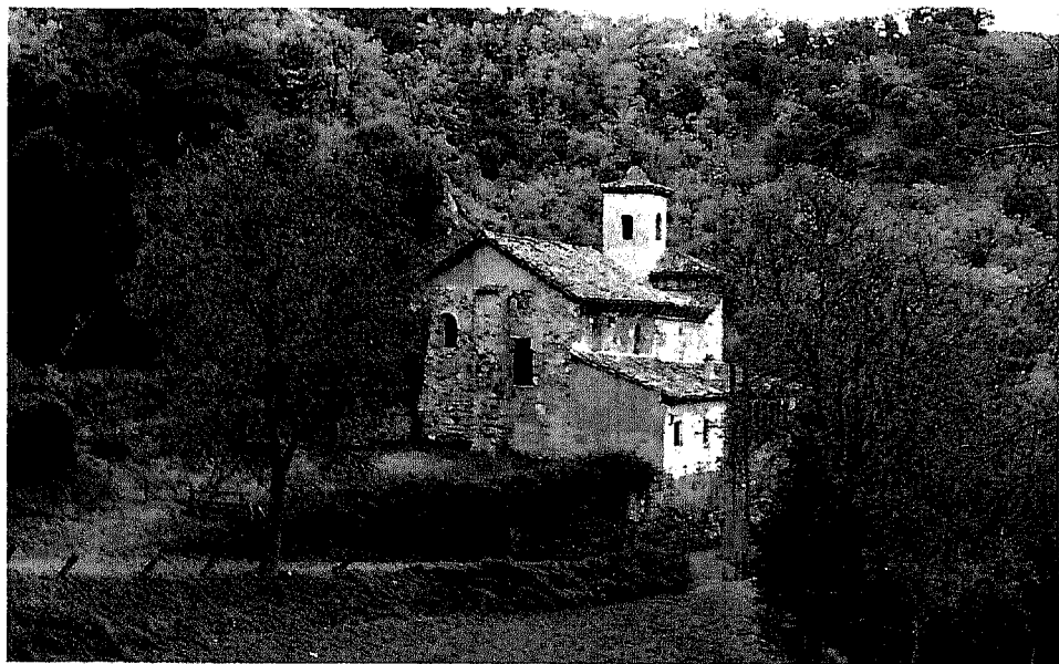
FOTO 6: Aspecto de la fachada Sur. El conjunto de la edificación tiene tendencia a inclinarse hacia el barranco. Las humedades que se acumulan en el subsuelo, delante de esta fachada, deterioran los cimientos y permiten esa deformación. En este terreno estaban las dependencias que se ven en la fotografías anteriores a 1935.
