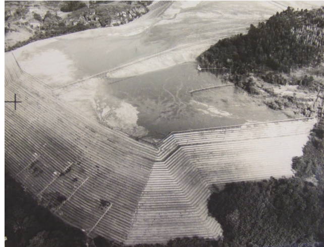
Figura 2. Detalles constructivos del recrecimiento del depósito poco antes de su rotura. Pueden apreciarse: 1) Las estructuras de vertido desde el contorno, 2) El escalonamiento resultante,, 3) Las manchas de vegetación en el talud debidas a la humedad y 4) La presencia de una importante laguna de decantación cercana al talud
