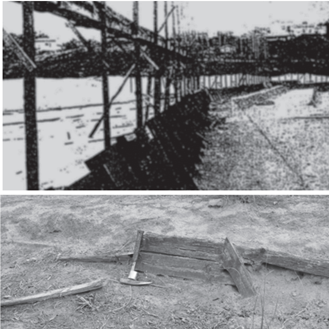
Figura 3. Arriba: fotografía del sistema de vertido durante el relleno del depósito en la década de los 60. Abajo: Vestigios de dichas estructuras encontrados en la actualidad Fuente: [1] y fotografía propia.
