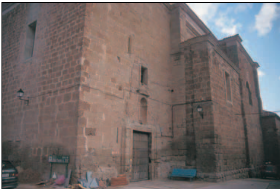
Lám. 3: Lado sur del exterior de la Iglesia.
