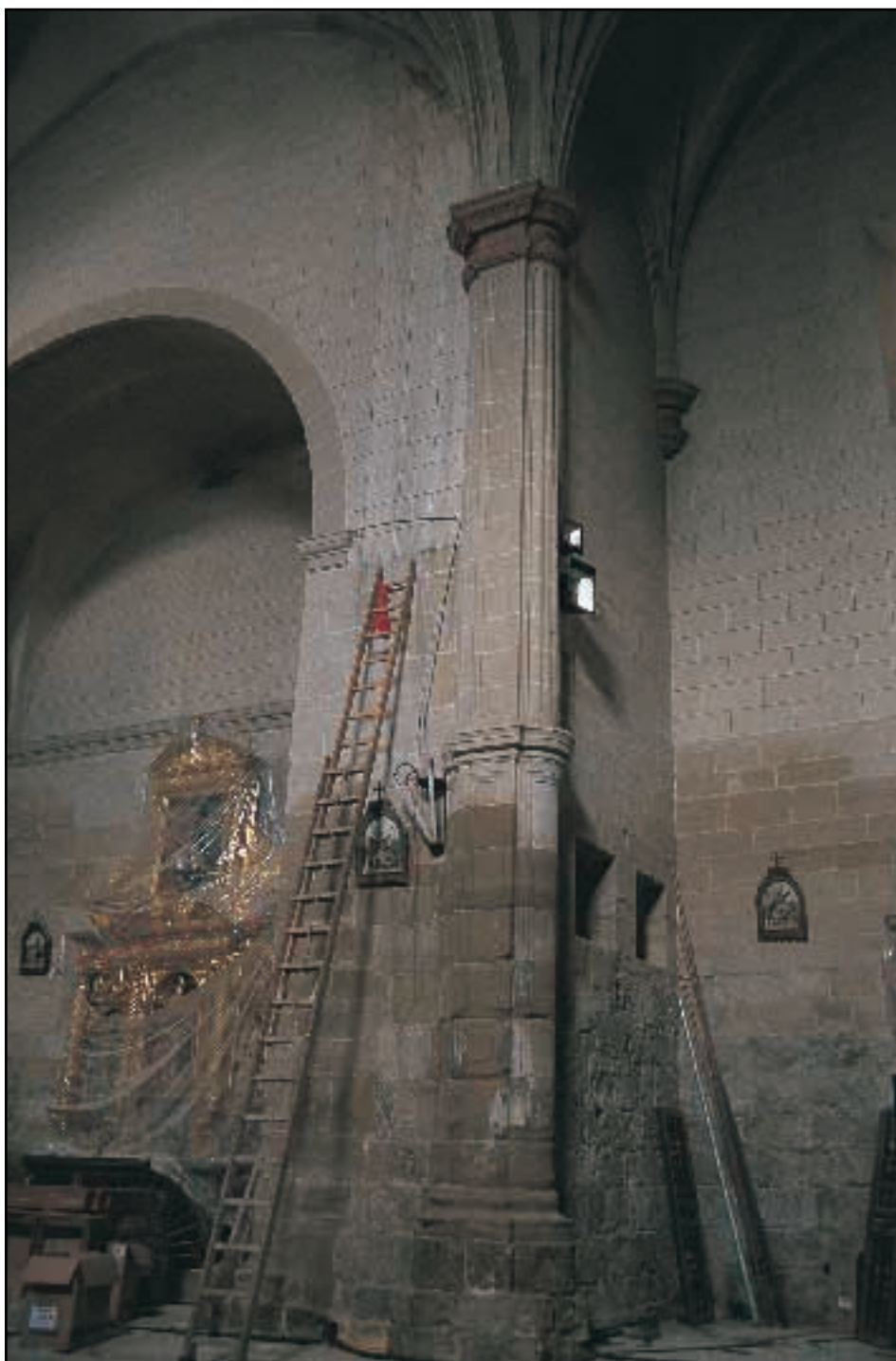
Lám. 5: Detalle de un pilar de la nave del Evangelio.
