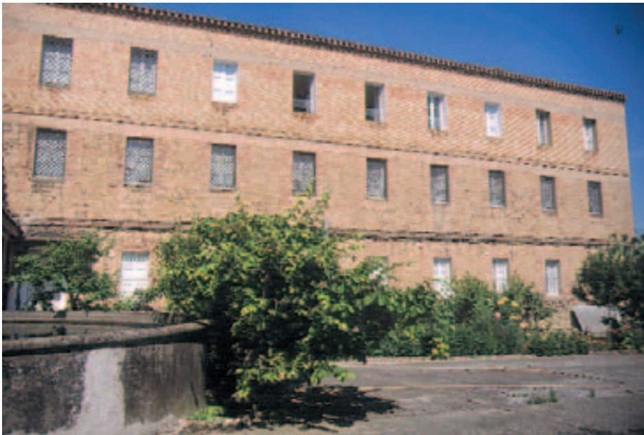
Lám. 7. Muro este de las dependencias conventuales.
