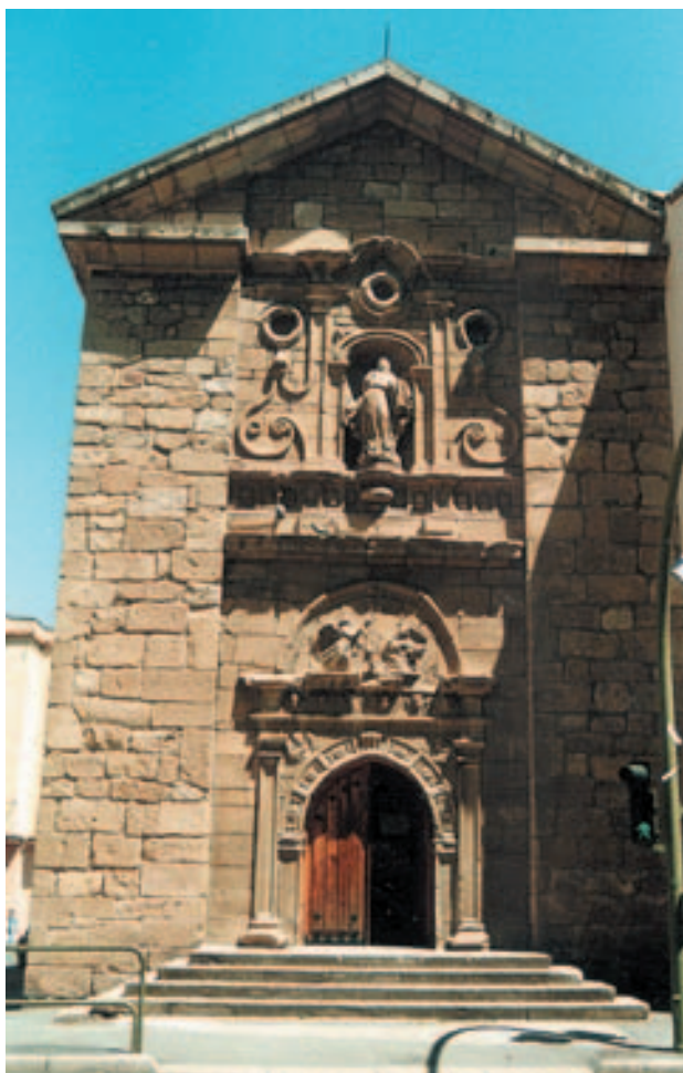
Lám. 3. Fachada de la iglesia del Convento de Madre de Dios.
