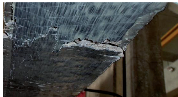
Figura 4. Rotura del refuerzo de fibras bajo carga puntual de viga V1.
