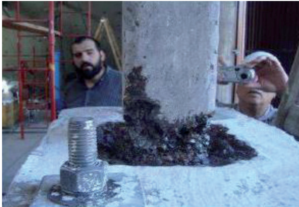
c) Mortero Aplicado en la zona de base de columnas. Figura 4. Rehabilitación de las bases de las columnas del pórtico.
