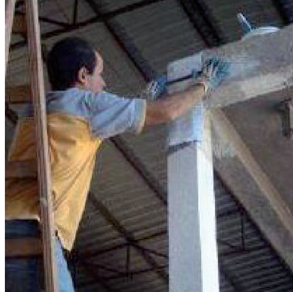
b) Colocación de fibra.
