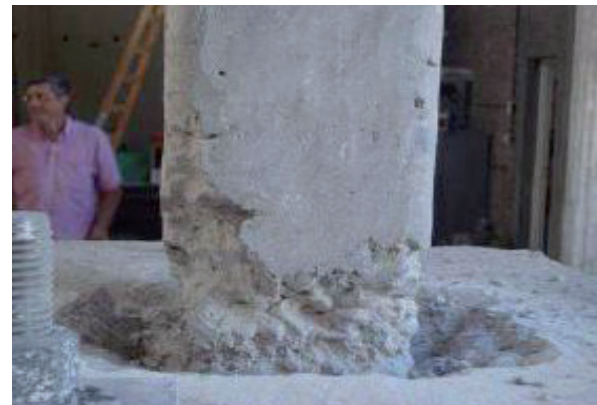
a) Hormigón eliminado en base de columnas.
