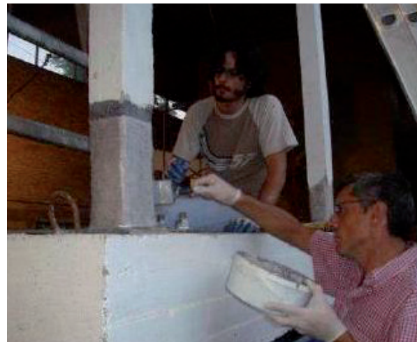
c) Colocación capa final de adhesivo.
