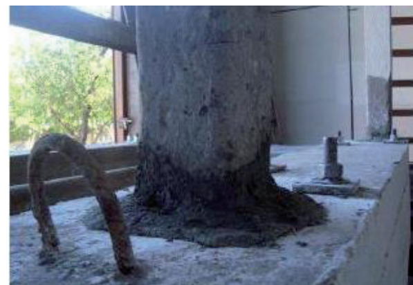
b) Adhesivo epoxi en zona de hormigón eliminado.
