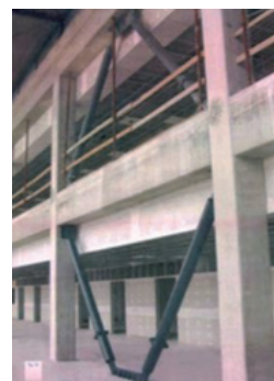
Figura 3. Sistema de BPR en estructura aporticada.
