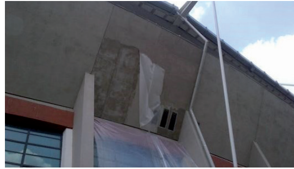
Figura 16. Aplicación de la tecnología FRCM para asegurar paneles de concreto del Estadio Olímpico (Turín). (a) Vista aérea del estadio (fuente: La Stampa). (b) Aplicación de las últimas capas del mortero de cal sobre las fibras y el refuerzo IPN. (Diseño estructural Ing. Gianluca Ussia).
