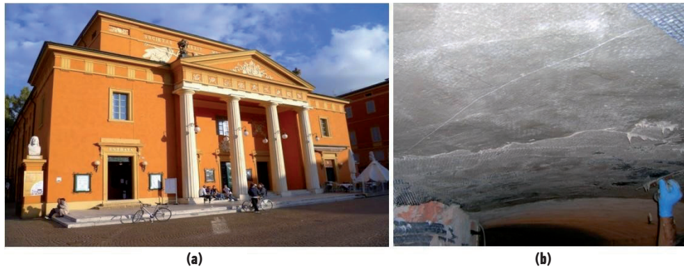
Figure 14. Reforzamiento antisísmico usando la tecnología FRCM y el sistema IPN en bóvedas de mampostería. (a) Fachada externa del Teatro de la Ciudad ed Carpi, Carpi – Modena. (b) Aplicación de las últimas capas del mortero de cal (Aplicación: Resin Proget Srl -Italy).
