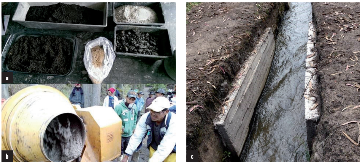
Figura 6. Dos tramos de prueba en Tungurahua, Ecuador: (a) Materiales en el sitio, (b) Mezcla del hormigón con apoyo de los agricultores, (c) Seis meses después, el flujo de agua en el canal no ha afectado la integridad de los tramos construidos.
