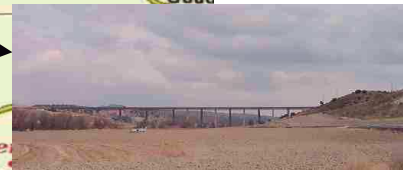
Puente FC "HACHO" sobre el río Guadahortuna
