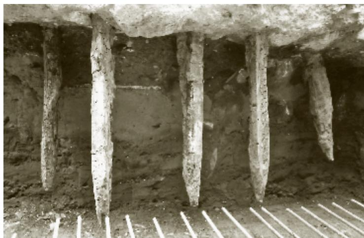
Figura 7. Cimentación de pilotes de madera
