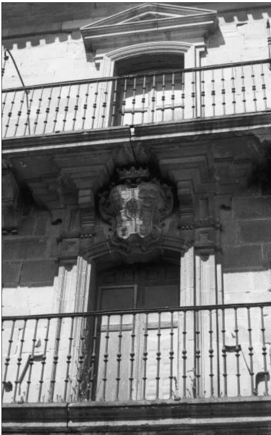
Palacio de Subiza. Fachada principal. Escudo de armas
