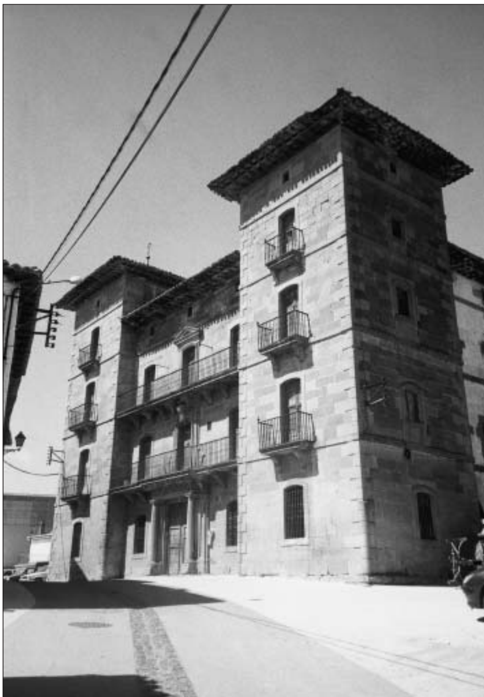
Palacio de Subiza. Fachada principal
