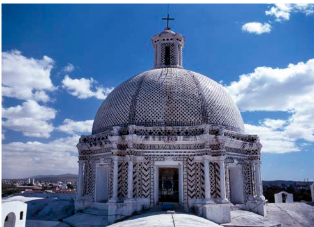
Cúpula de la iglesia de la Soledad. Puebla de los Ángeles, México.
