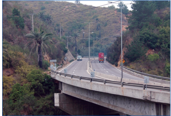
Fot. 4 - Colinas con agrupaciones de palmas disectadas por la construcción de carreteras.
