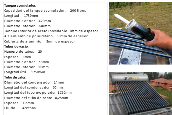
Figura 15. Características de calentadores solares instalados
