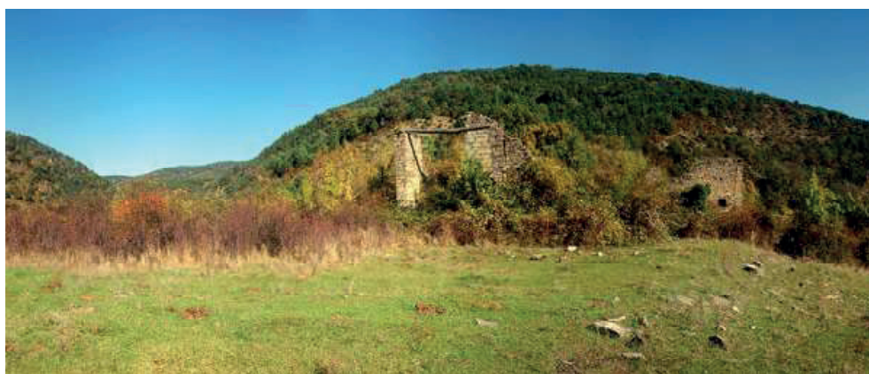
Cerréncano hace escasos años, totalmente derruido. Fue demolido entre 2003/2006 cuando apenas quedaban unos cimientos con unas vigas caídas.
