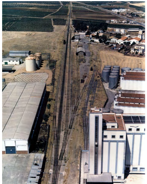
Vista general de la estación. Fuente: RENFE. 1989
