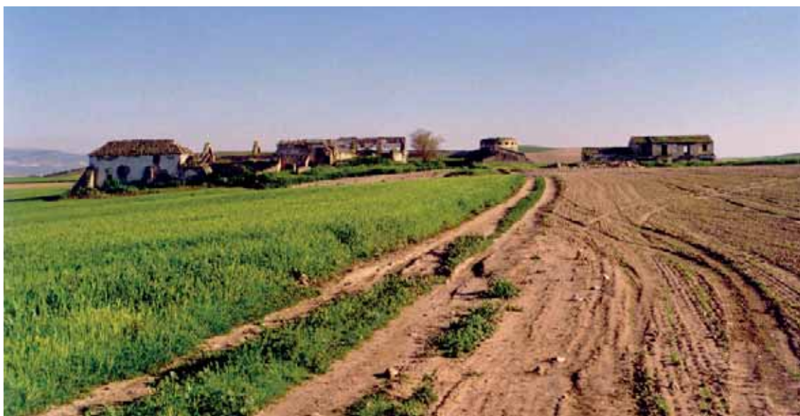
VISTA DEL CONJUNTO TAL COMO SE ENCONTRABA EN 2002. EN PRIMER TÉRMINO EL CORTIJO GALLAPE; AL FONDO LAS EDIFICACIONES DEL S. XX
