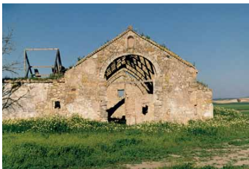
IMAGEN DEL ALZADO DE ACCESO A LA NAVE DEL TINADO DEL CORTIJO GALLAPE
