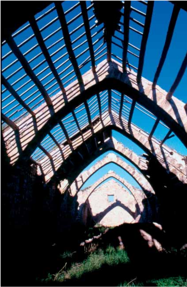
VISTA DEL INTERIOR DE LA NAVE
