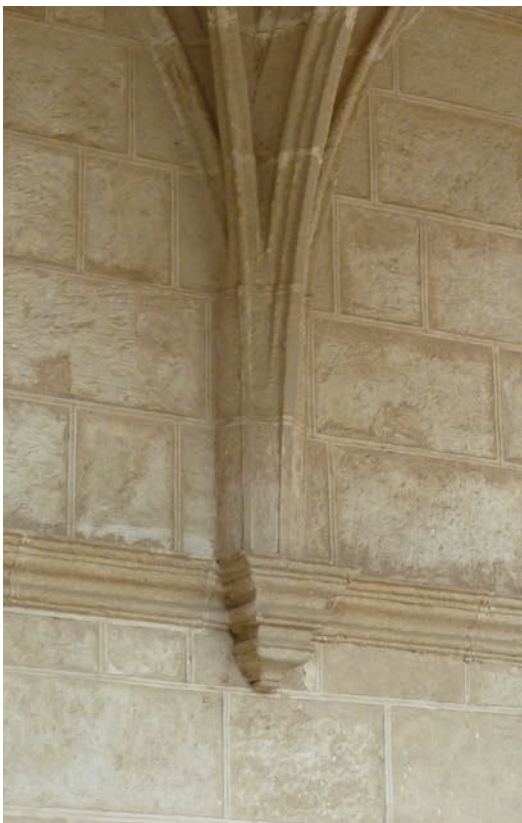
▪ Fig. 7. Cartuja de la Defensión, Jerez de la Frontera. Detalle de enjarje de bóveda en el claustro. Foto de los autores.
