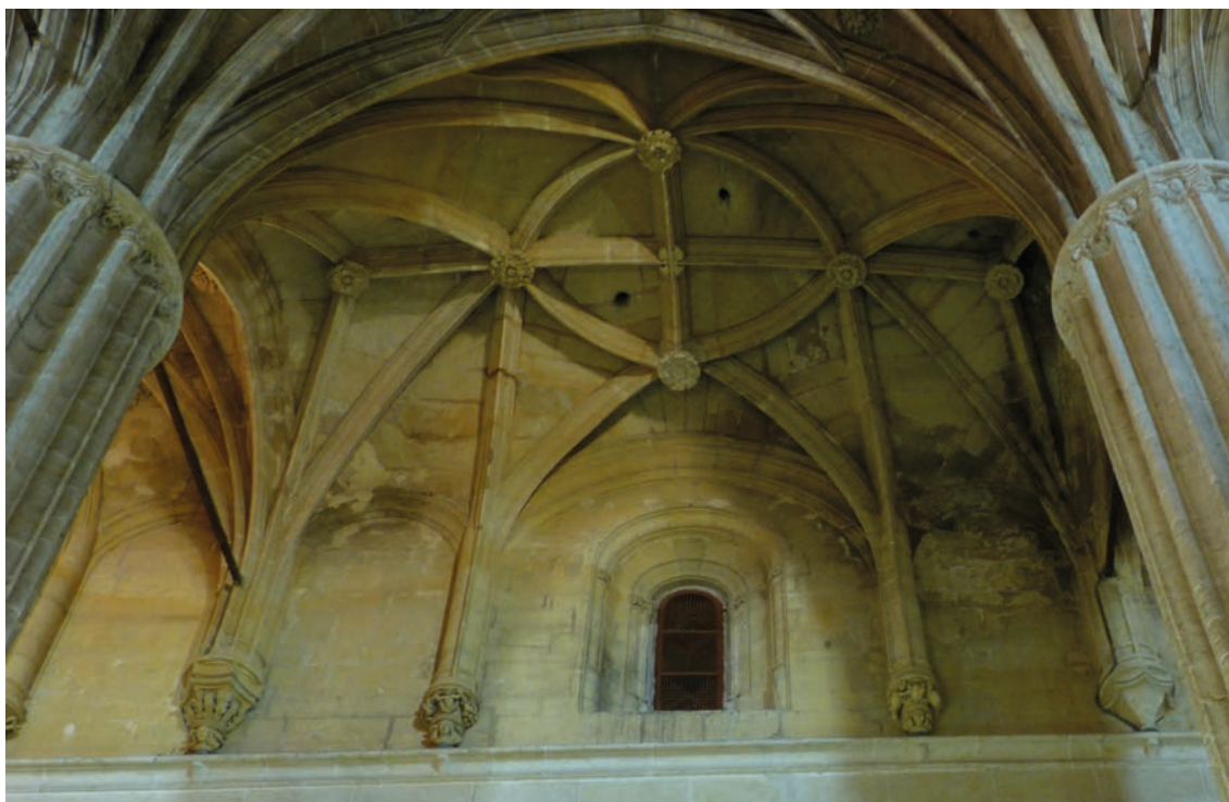
▪ Fig. 9. Iglesia de Santa María, Arcos de la Frontera. Detalle del enjarje de los nervios de la bóveda en el muro. Foto de los autores.
