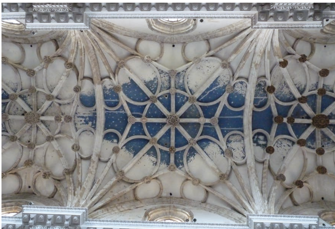
▪ Fig. 3. Cartuja de la Defensión, Jerez de la Frontera. Tramos de bóvedas de los pies de la iglesia. Foto de los autores.
