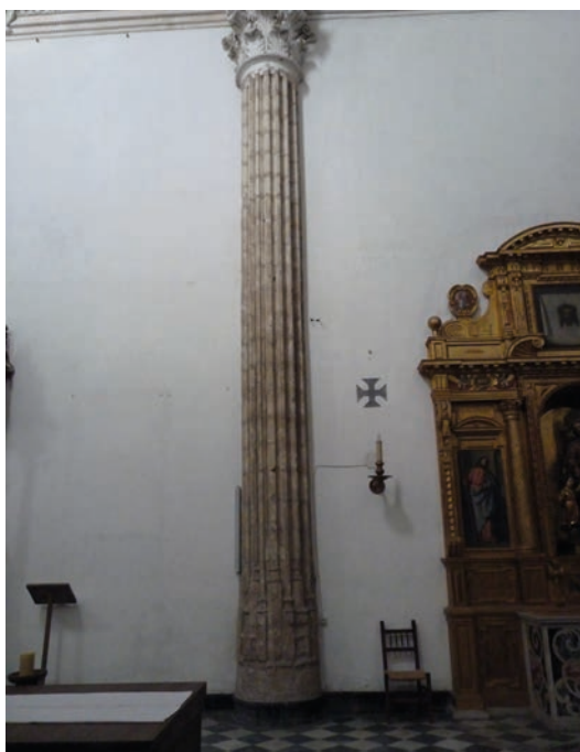
▪ Fig. 5. Cartuja de la Defensa, Jerez de la Frontera. Detalle del pilar adosado al muro de la iglesia. Foto de los autores.
