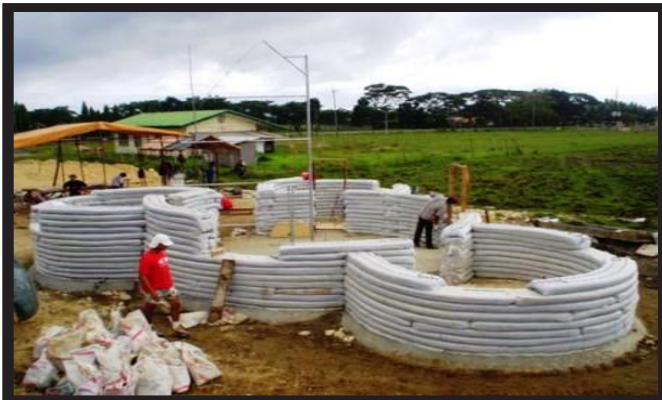
Figura 4. Uso del superadobe en las construcciones
