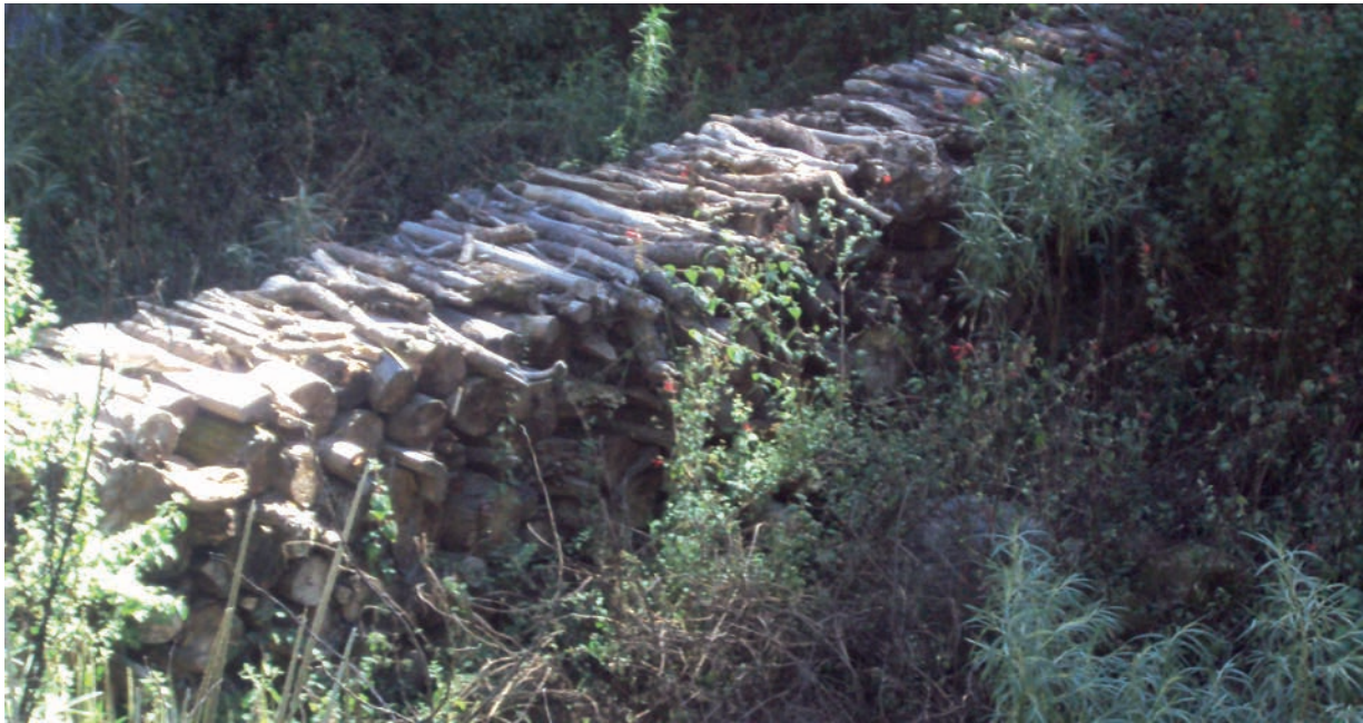
Figura 2. Presa de ramas en el Ejido de Tequexquahuac. Figure 2. Branch dams in Ejido de Tequexquahuac.
