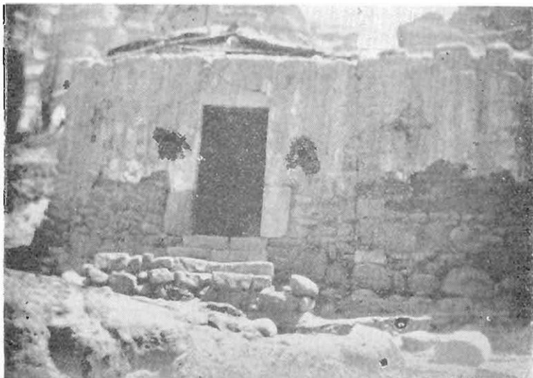
Fig. N° 7.— Tipo de vivienda pobre y poco frecuente: paredes de piedra, adobe y sillar, techo de estera y piso de tierra.
