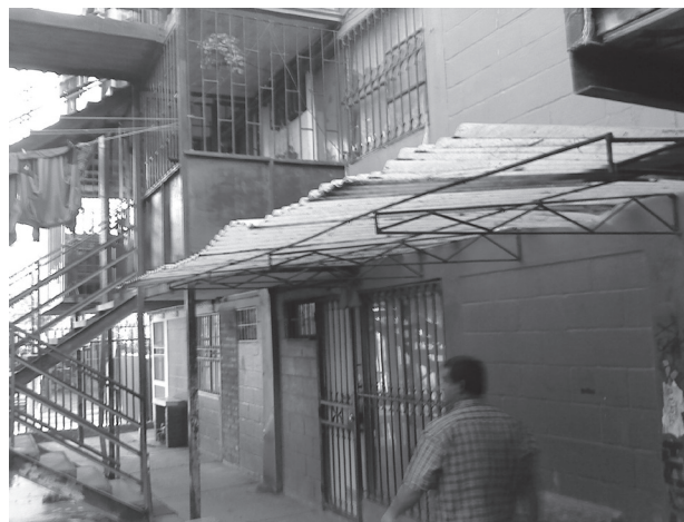
Imagen D: Paso bajo Balcones
