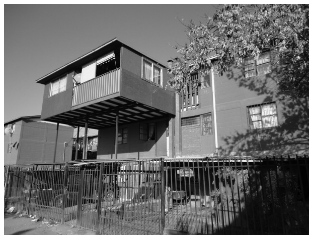
Imagen B: Ampliación sobre pilares
