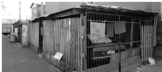
Imagen F: Tomas de anchos irregulares destinadas a bodegajes
