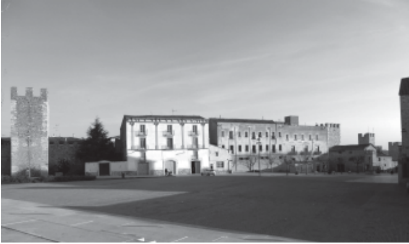
Vista general de les edificacions adossades a la muralla a la banda de ponent del portal de Sant Francesc. Al'extrem esquerre la torre, cal Contijoch, cal Ferreret i l'edifici del Kursaal
