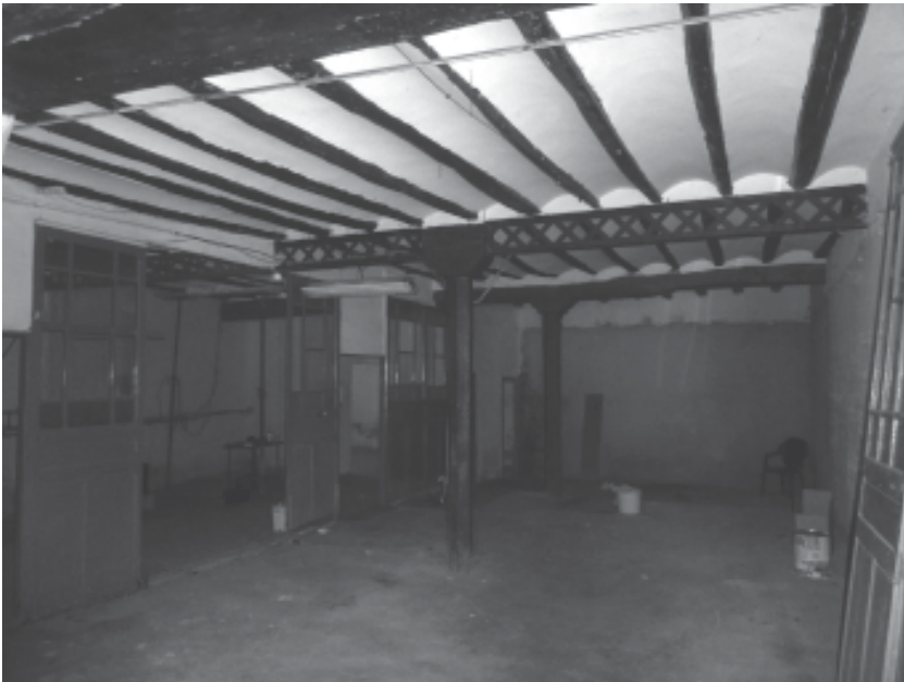
Vista de l'interior de la planta baixa de cal Masalles abans de les obres de 2016
