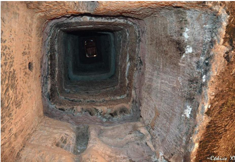
**Chimenea o “zarcera”, que sirve de conducto de ventilación a todo el conjunto**
