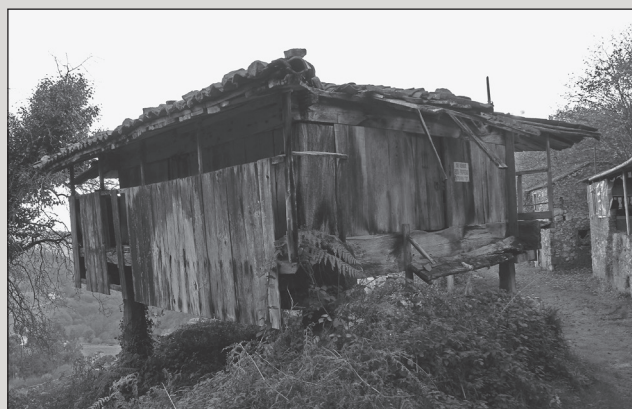
HÓRREO DEL S XVI EN EL HORRO, CASA ANTÓN DE TARECHA, EN AVANZADO ESTADO DE DETERIORO. FOTO DEL AUTOR
