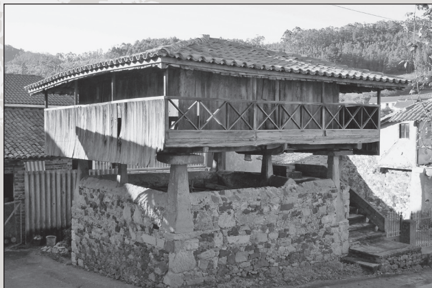
HERMOSO EJEMPLAR DE HÓRREO EN CA ROMANO DE LES CRUCES, CON CORREDOR CON MANDIL DE TABLA Y BARANDILLA EN ASPAS. SE APRECIA CÓMO SE REDUCE ABERTURA CON VOLUMEN INFERIOR RECRECIDO CON MURO DE MAMPOSTERÍA. FOTO DEL AUTOR
