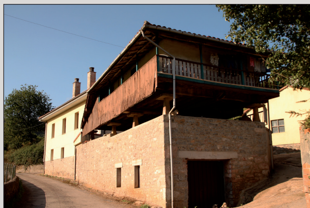
EJEMPLAR DE HÓRREO EN CA LLUIS RECONSTRUIDO POR REGIONES DEVASTADAS EN POSGUERRA, CON TABIQUERÍA DE LADRILLO. FOTO DEL AUTOR
