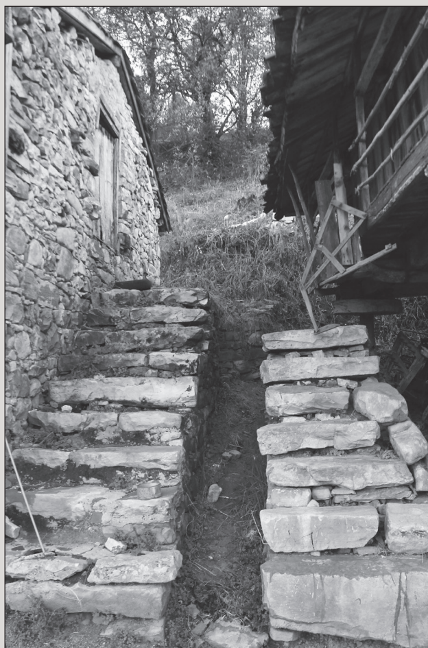
DETALLE DE LA SUBIDORIA O PATÍN DE ACCESO A UNA PANERA EN EL HORRU COGOLLO. FOTO DEL AUTOR
