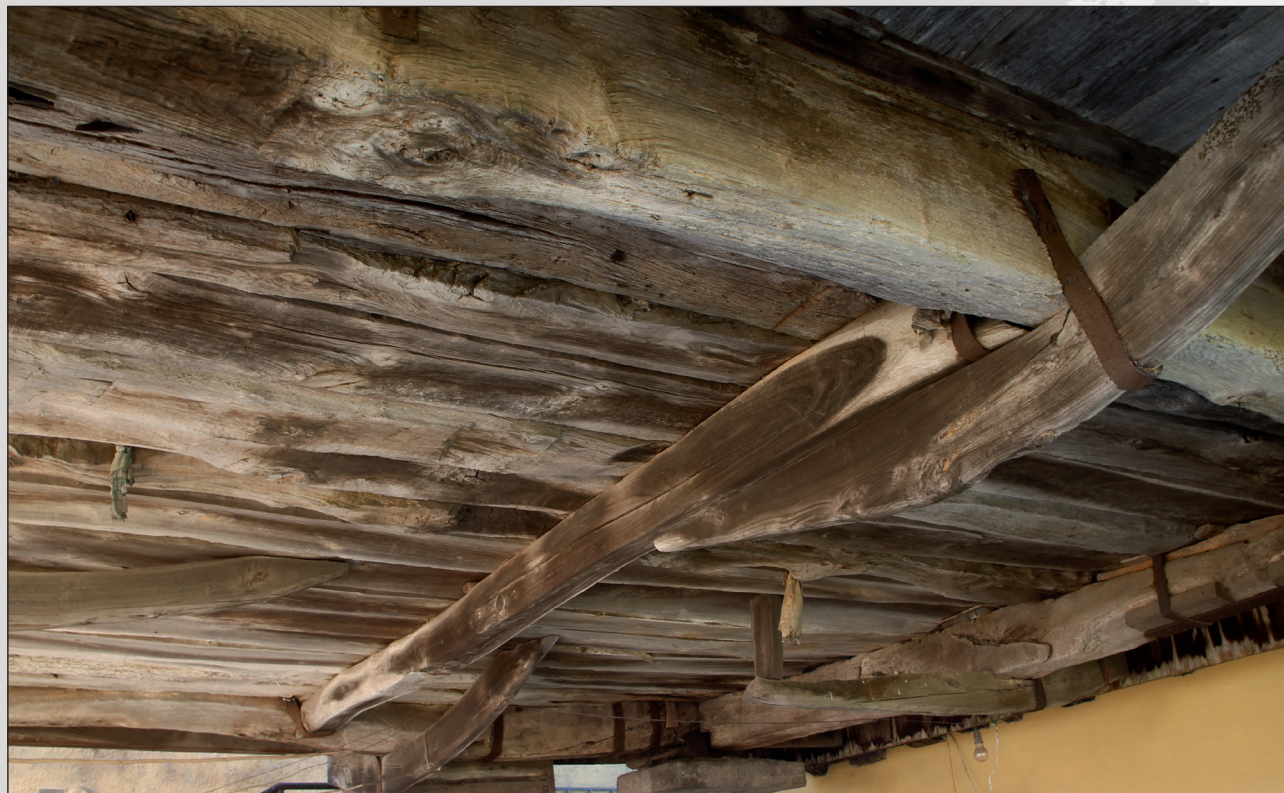
DETALLE DE LOS ALMANQUES CON LOS CUALES SE ADICIONA UN CORREDOR A UN HÓRREO CONSTRUIDO ORIGINALMENTE SIN ÉL, CASO MUY EXTENDIDO EN TRESMONTE. FOTO DEL AUTOR
