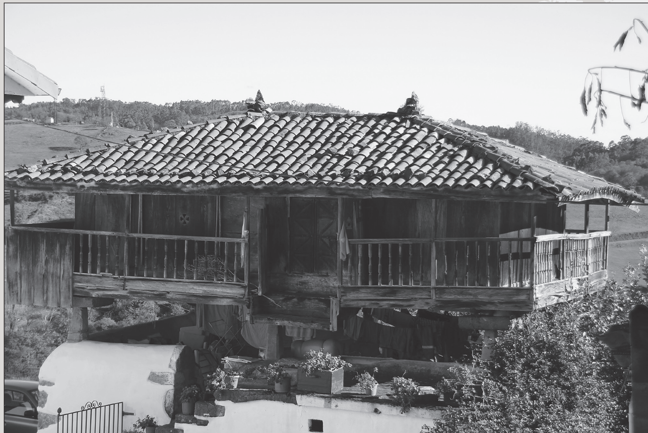
PANERA EN LA PIENDA. CORREDOR AÑADIDO AL CUERPO ORIGINAL. DECORACIÓN DE PUERTA ZIGZAGUEADO EN LOS CUARTERONES Y FLOR TETRAPÉTALA EN VANO DE VENTILACIÓN. FOTO DEL AUTOR
