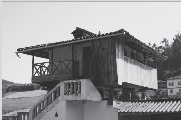
HÓRREO EN CA XUACU, AGÜERA. SE PERCIBE EL CONTRASTE ENTRE EL VOLUMEN INFERIOR, ANTIGUO, Y EL CORREDOR, CON BARANDILLA DE ASPA, MANDIL TORNAGUA Y BUFARDA. FOTO DEL AUTOR
