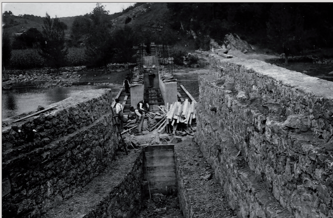
FOTO DEL PUENTE EN CONSTRUCCIÓN FECHADA EL 29 DE SEPTIEMBRE DE 1930. FOTO CEDIDA POR JOSÉ LUIS MARTÍNEZ QUINTANA
