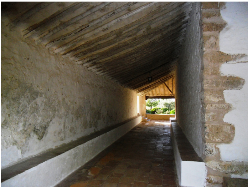
Fig. 3: Lateral con su cubierta y el poyo corrido.
