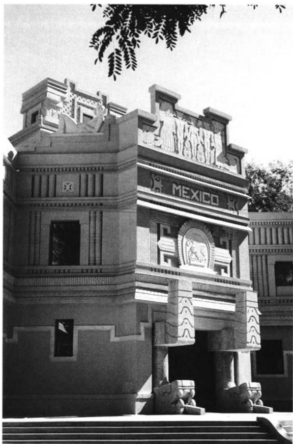
Figura 4- Estado actual de la fachada principal del Pabellón de México.
