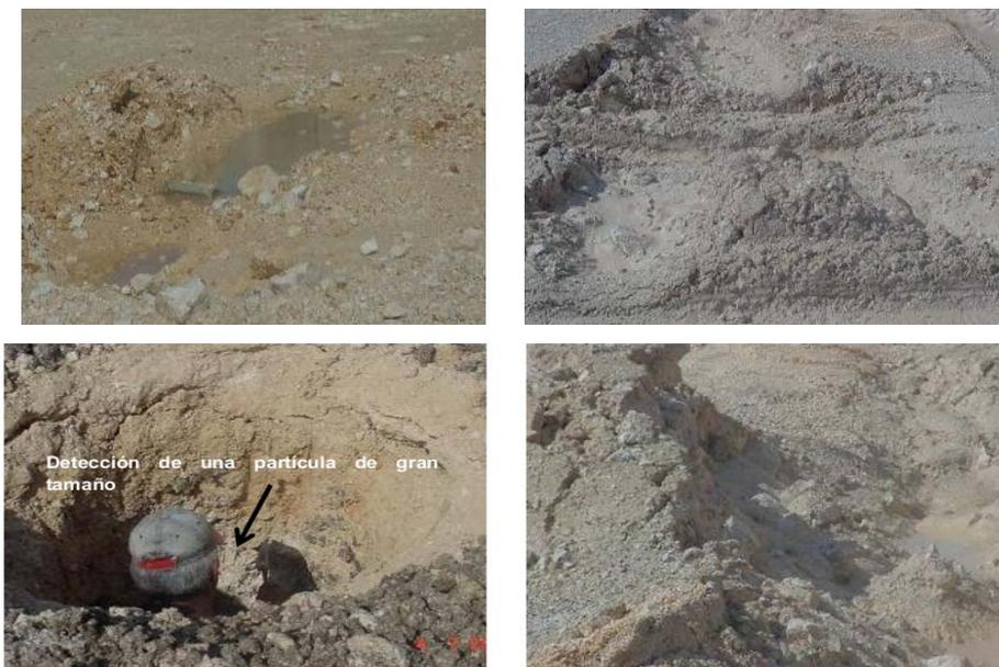
Figura 5: Resultados de una mala compactación producto de la presencia de partículas más grandes que las permisibles dentro de las capas ejecutadas. Fuente: autores
