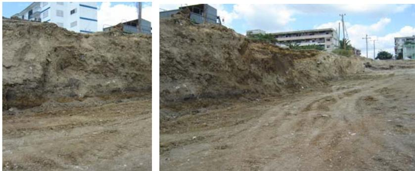
*Figura 1. Relleno de espesor variable con características inapropiadas. Urbanización provincia de Cienfuegos.
