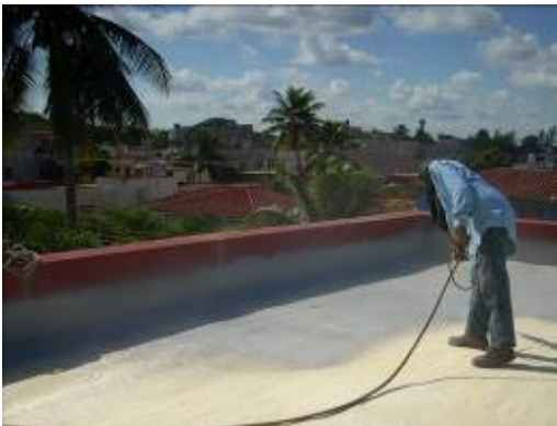
Figura 6. Aplicación de la primera capa de protección a la espuma rígida mediante una membrana elastomérica de base acrílica. Foto de las autoras.
