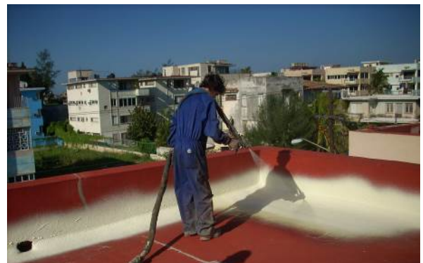
Figura 5. Primera capa de espumación. Foto de las autoras.
