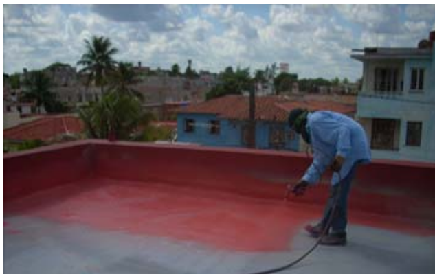
Figura 7. Aplicación de la segunda capa de protección a la espuma rígida mediante una membrana elastomérica de base acrílica de color diferente a la primera capa. Foto de las autoras.
