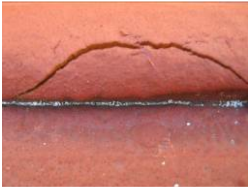
Figura 14. Grieta en forma de media luna. Obra: Instituto de Investigaciones de la Cultura Juan Marinello. Fotos de las autoras.
