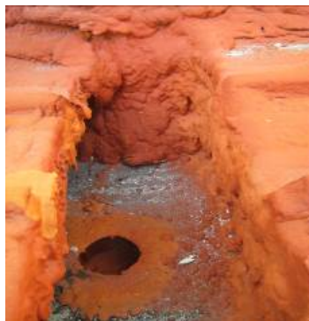
Figura 13. Descuelgue de las capas de espuma. Obra: Instituto de Investigaciones de la Cultura Juan Marinello. Foto de las autoras.
