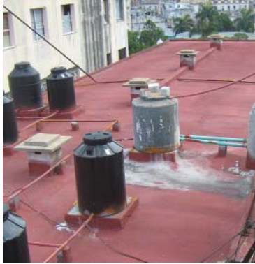
Figura 5. Depósito de sales en cubierta. Obra Escuela Nacional de Ballet. Foto de las autoras.
