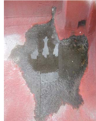
Figura 3. Agua estancada en la cubierta sur de la Escuela Nacional de Ballet. Foto de las autoras.
