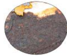
Figura 11.2. Corrosión localizada debajo del área ocupada por una ampolla
