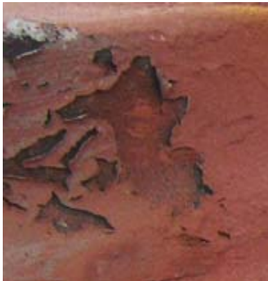
Figura 10. Pérdida de adherencia de la espuma por restos de material asfáltico Obra. Café Teatro Bertolt Brecht Foto de las autoras
