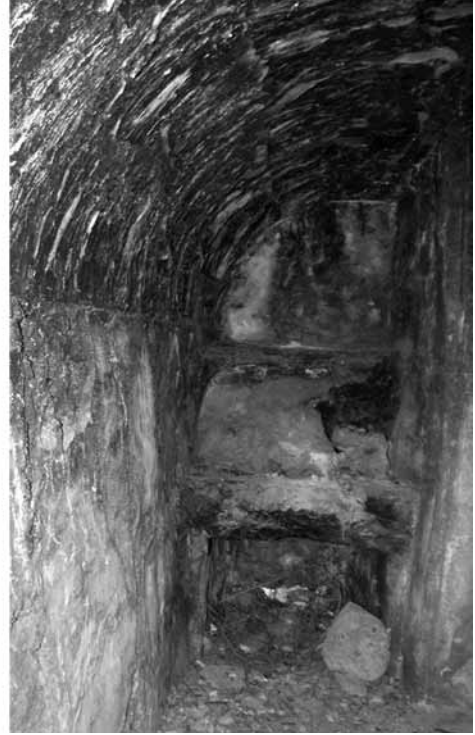
Chimenea de la Era Hueca.
