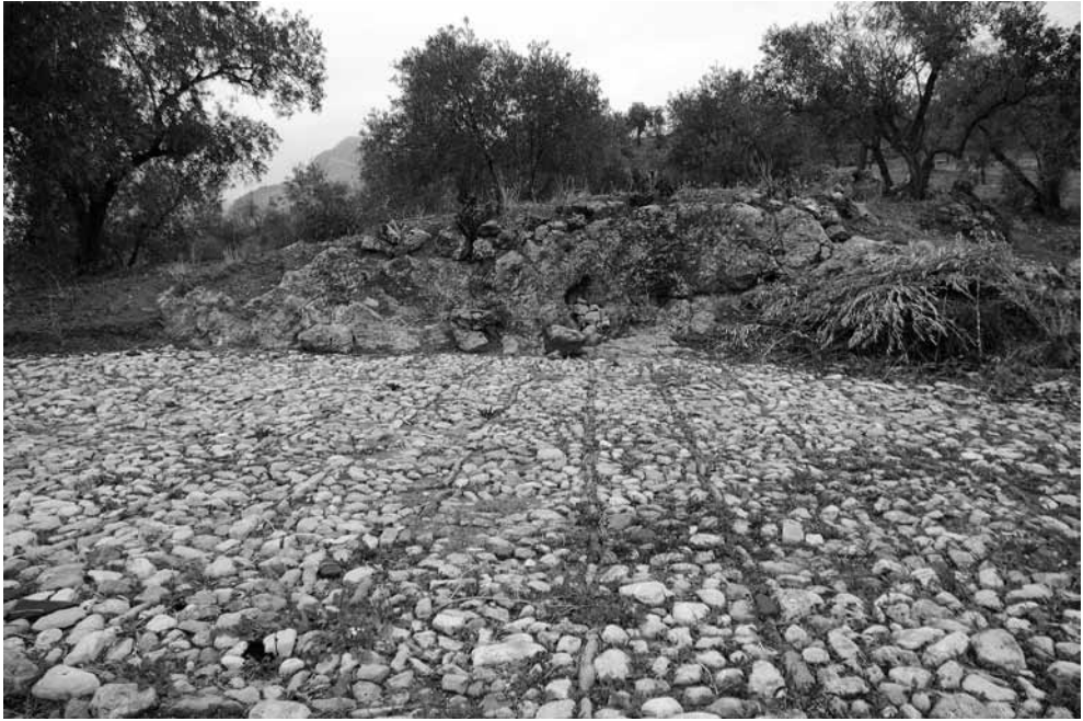
Era de "Chirivas": construida aprovechando el desnivel de una pedriza natural.
