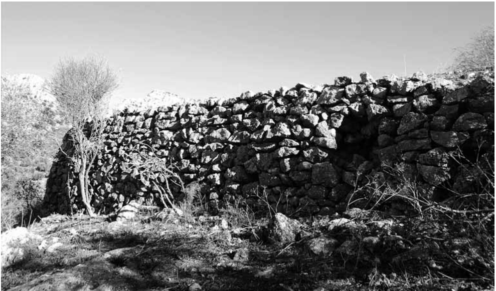
Muros de contención de la Era de la Pedriza de Elías: en su parte norte y oeste son de 2 m de altura.
