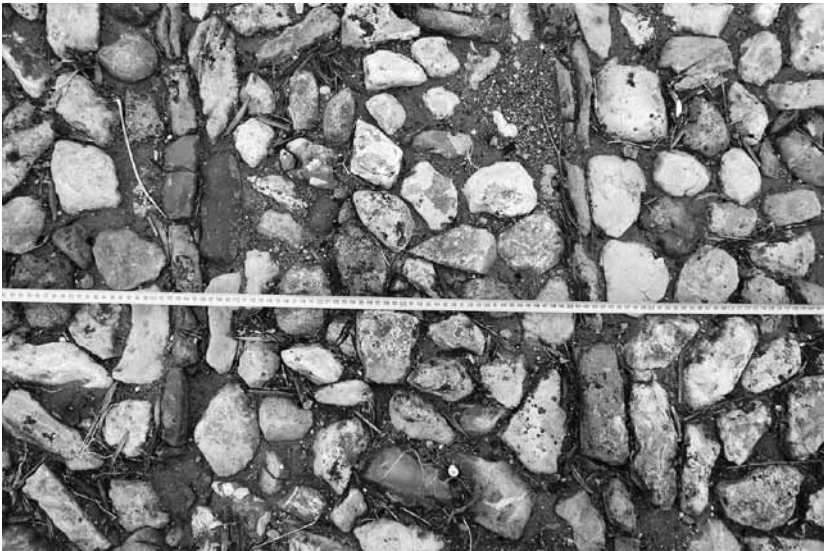
Destalle del empedrado.
