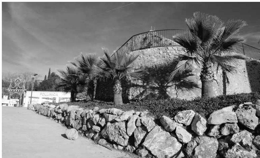
Muro de contención de la Era.
