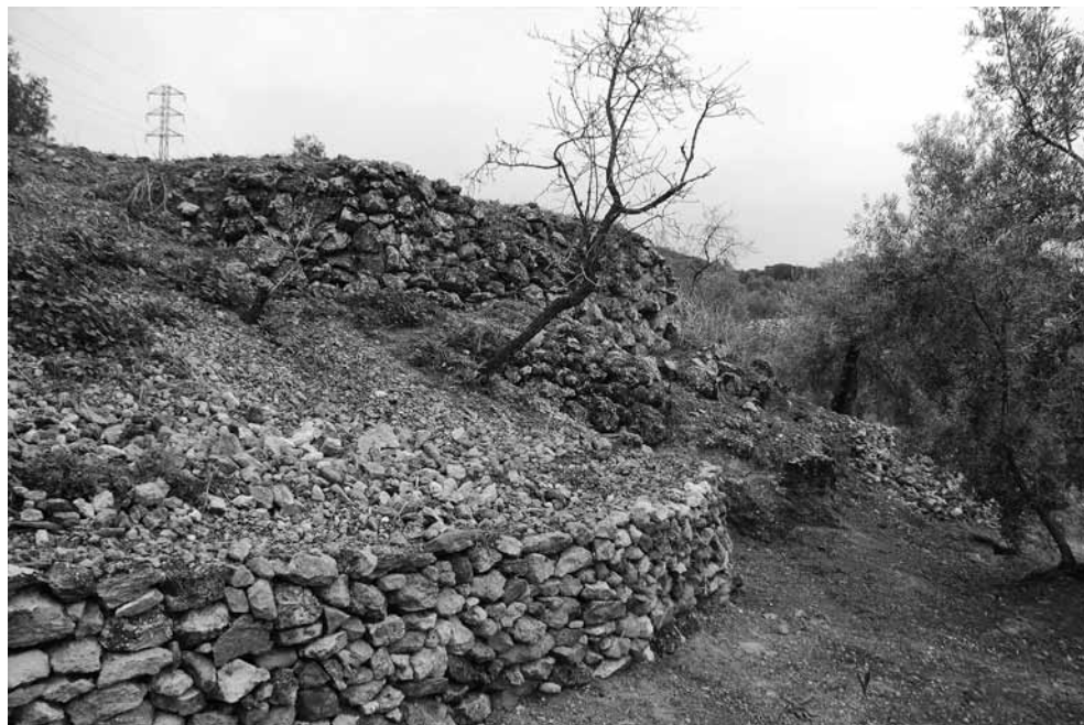
Era de “Chirivas”: muro de contención para la nivelación de la era.
