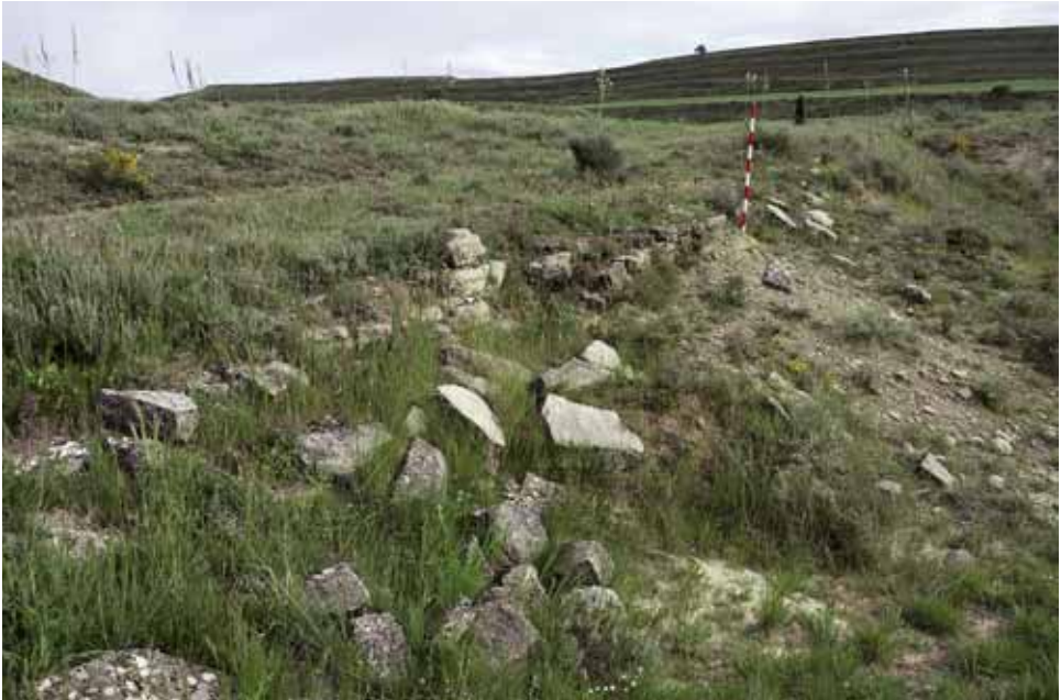
Fig. 7. Muro lateral (ETRS89 30T. X: 706003; Y: 4661956).
