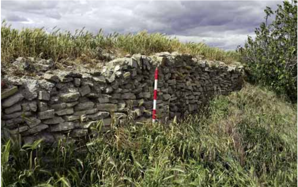
Fig. 1. Muro del terraplén junto al cementerio de Almudévar (ETRS89 30T. X: 700510; Y: 4657982).
