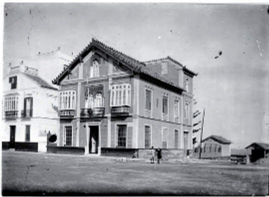
Figura 1. Edificio de la Estación de Biología Marina de Málaga. Archivo Laboratorio Oceanográfico. IEO.
