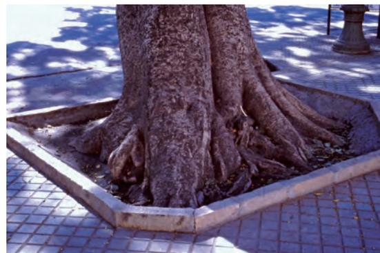
Figura 15. Alcorque insuficiente (*Ficus microcarpa*).
