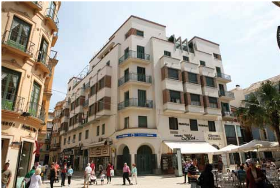
Edificio de calle Granada. José González Edo.
