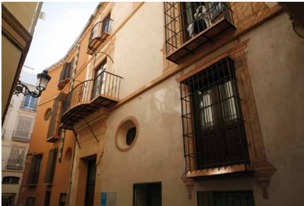
Edificio de estilo barroco s. XVIII, calle Medina Conde 3.
