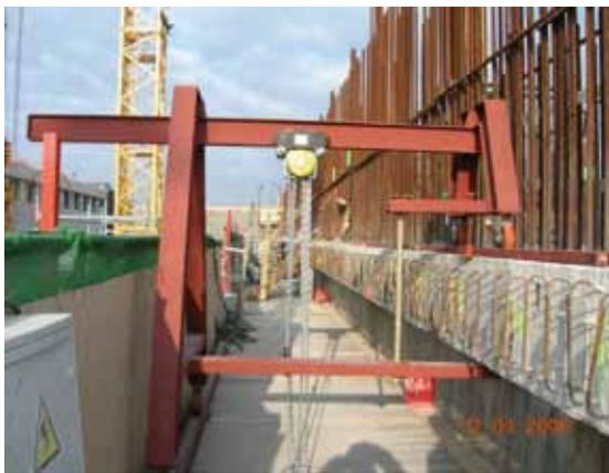
Figura 7. Pórtico de tesado sobre plataformas.
