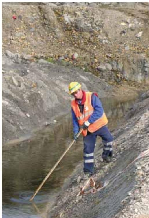
Figura 9. Mantenimiento rutinario de los canales de drenaje.
