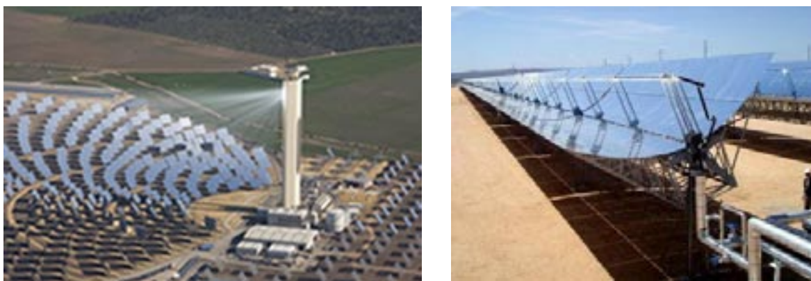
Fig. 7. Central de torre de Sanlúcar la Mayor (izda.) y central de cilindro-parabólicos Andasol
