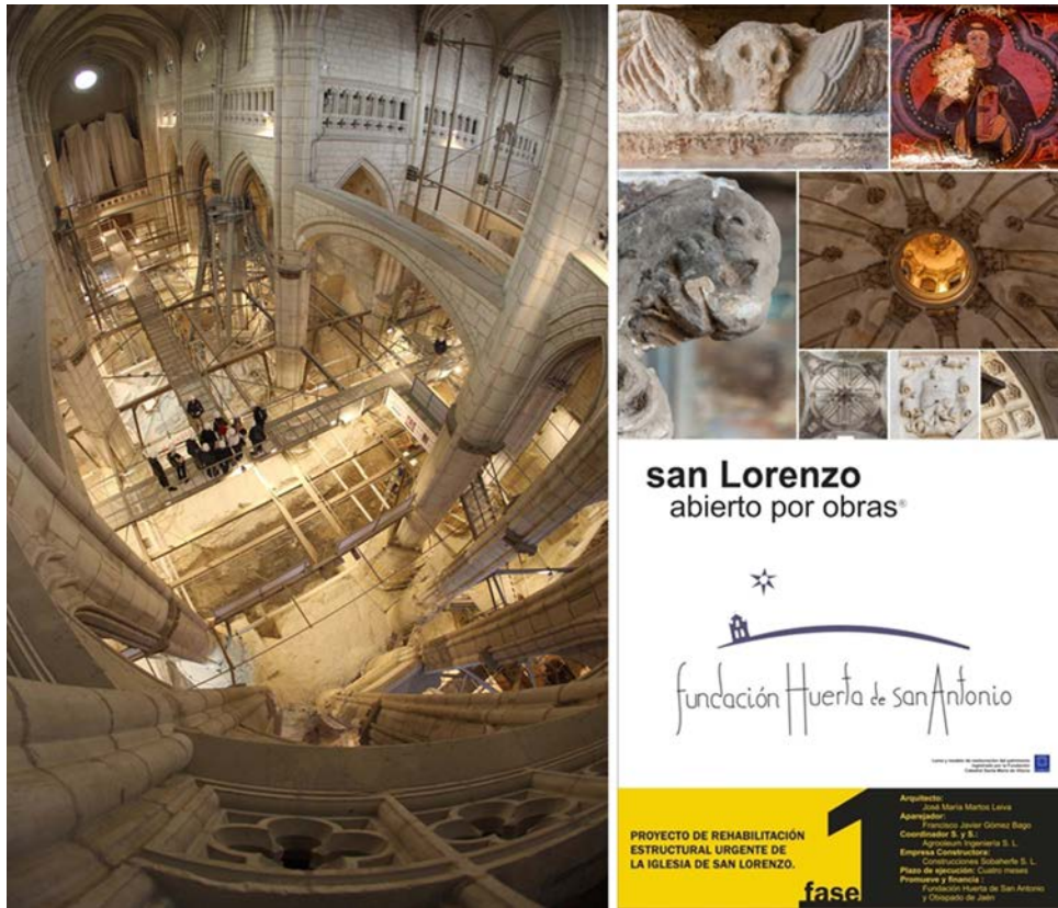
Figura 5. Abierto por obras de la Catedral de Vitoria y de la Iglesia de San Lorenzo de Úbeda. Fuente: Fundación Huerta de San Antonio.
