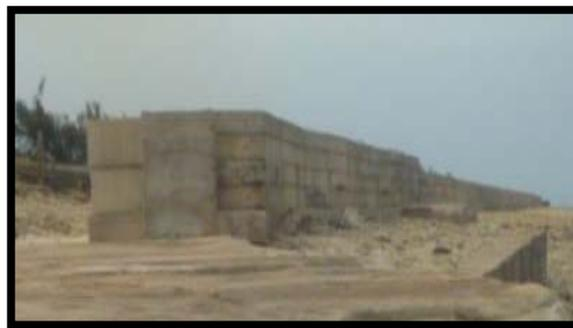
Se observó además socavación de la parte delantera y trasera del sello como se observa en las siguientes fotos:
