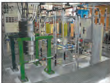
Figura 10.- Planta piloto industrial del Departamento de Química Física de la Universidad de Alicante
