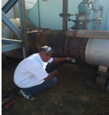
**Figura.** Punto de muestreo para cada uno de los motores.
