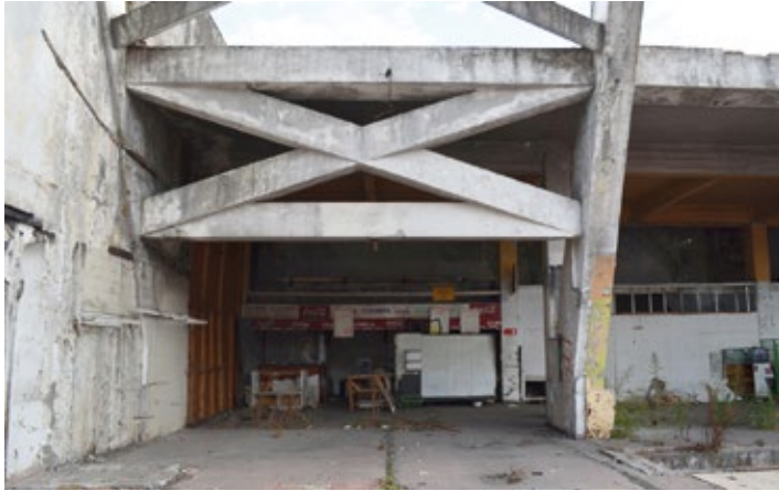
Figura 5 Crucetas de hormigón armado, Mercado Central de Concepción, 2015. Autor: Camila Salazar.
